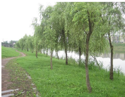
主体工程栽植乔木 (2021.5)
