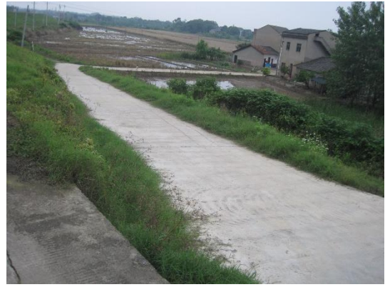
施工便道整治恢复
