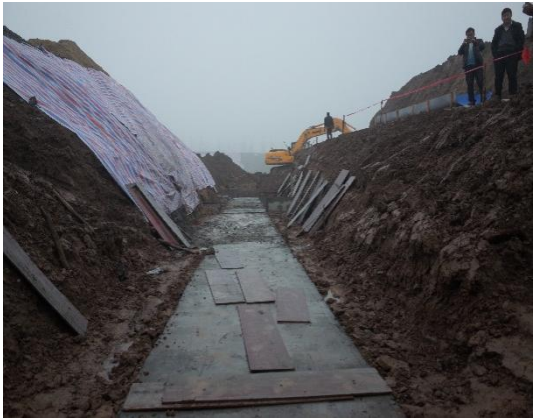
主体工程临时覆盖
