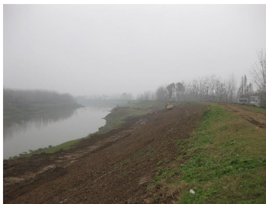
坡面土地整治 (2016.2)
