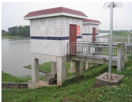
涵闸重建恢复（2021.5）
