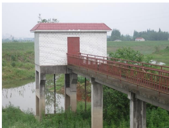
涵闸重建恢复（2021.5）
