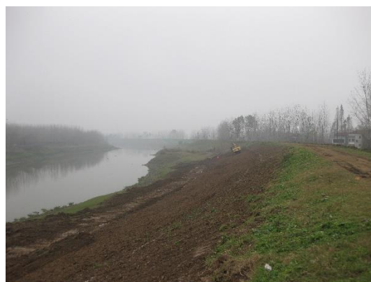
坡面土地整治
