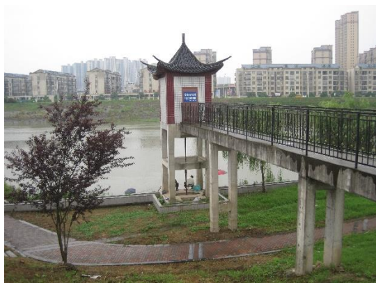
涵闸重建恢复（2021.5）
