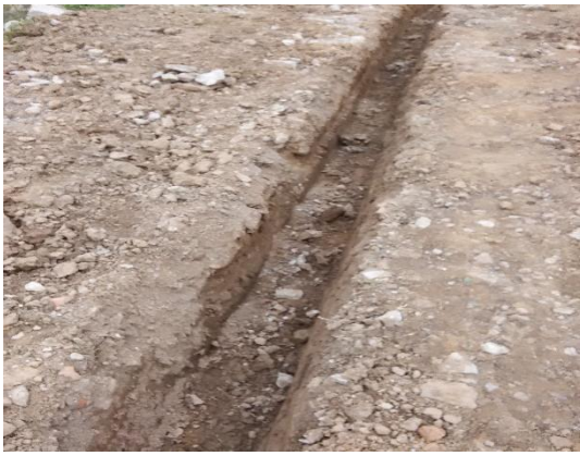
主体工程临时排水
