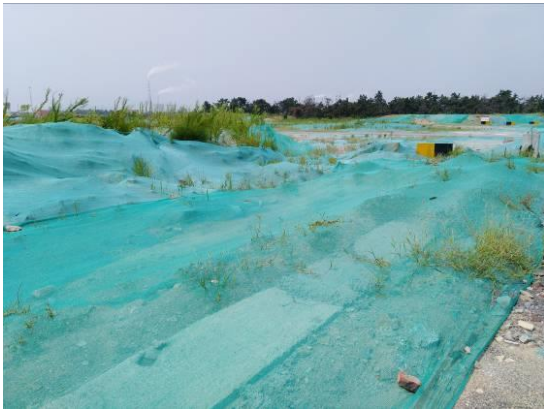
主体工程区临时堆土覆盖
