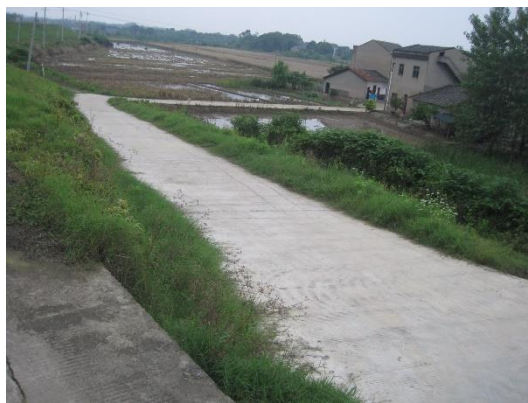
施工便道整治恢复 (2021.5)
