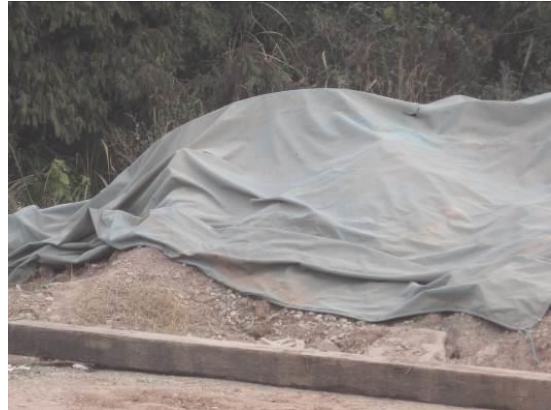
取土场临时覆盖
