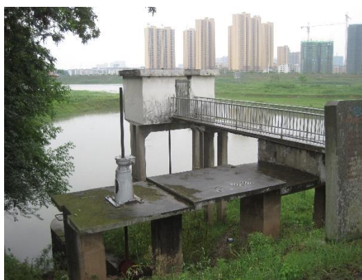
涵闸重建恢复（2021.5）
