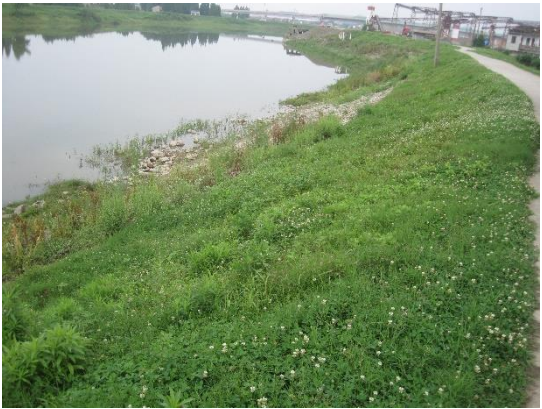
主体工程边坡植草
