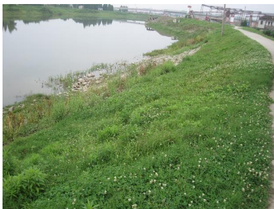
主体工程边坡植草 (2021.5)
