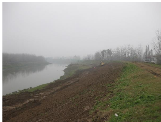
坡面土地整治（2016.2）
