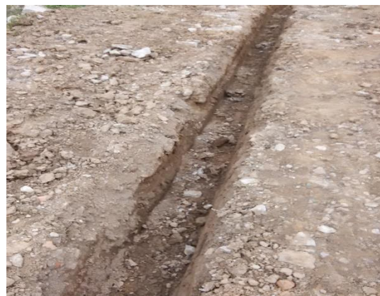
主体工程临时排水（2015.11）
