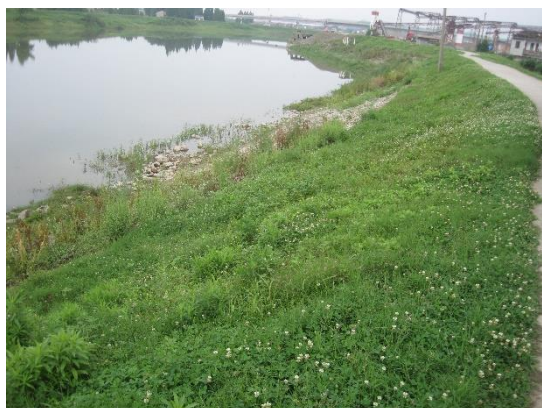
主体工程边坡植草 (2021.5)
