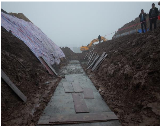
主体工程临时覆盖（2015.11）
