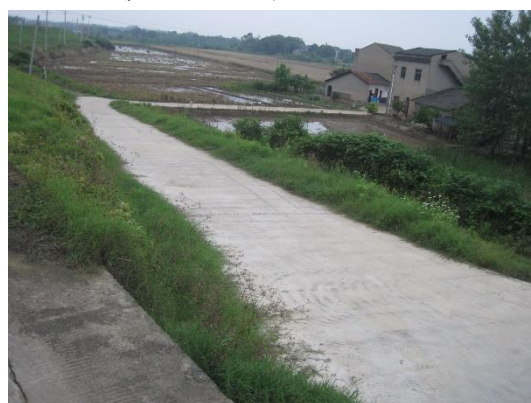
施工便道整治恢复（2021.5）
