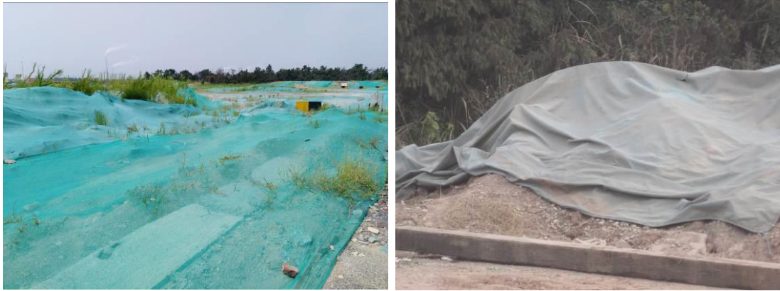
施工生产生活区临时堆土覆盖（2015.11）
