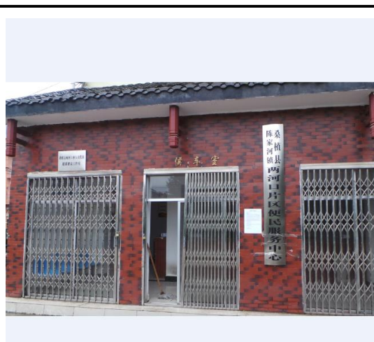
陈家河镇两河口片区
