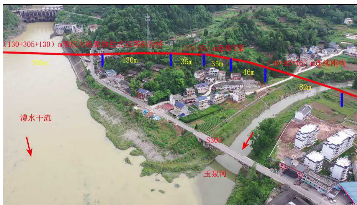
贺龙特大桥桥址处照片
