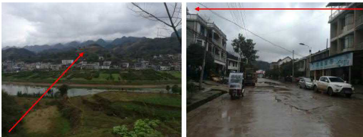
图 2.6-3 两河口澧水大桥桥址区实景图
