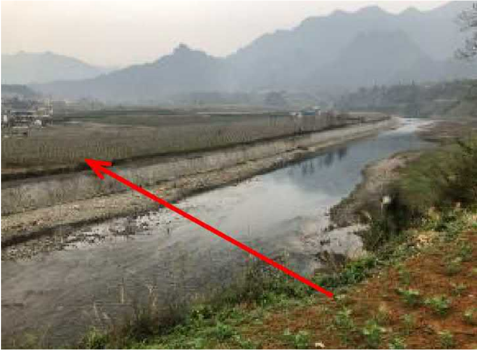
图 2.6-5 陈家河大桥的桥址区实景图
