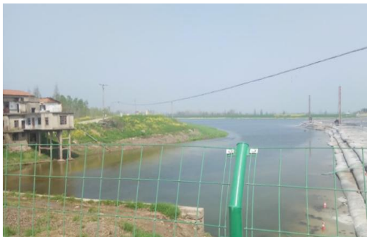
原六门闸闸址上游
