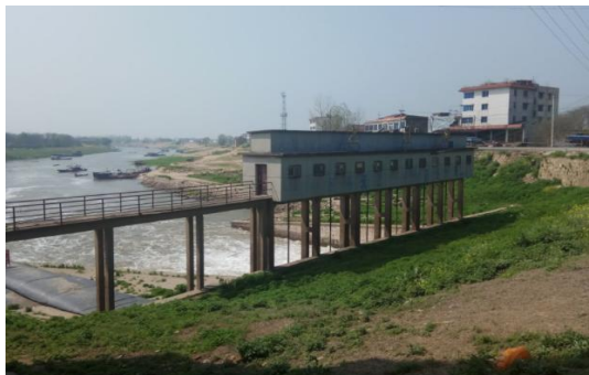
原六门闸闸址及下游
