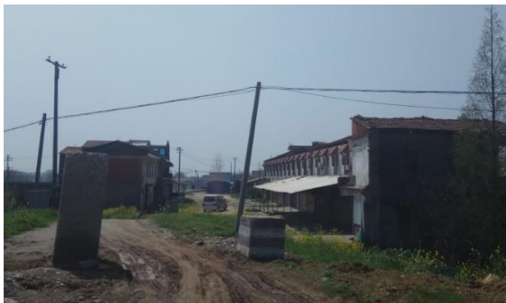
施工营地布置处
