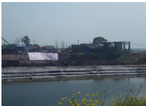
六门船闸围堰
