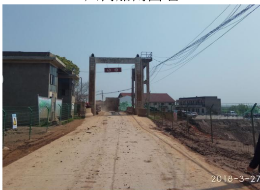
现有闸顶交通桥
